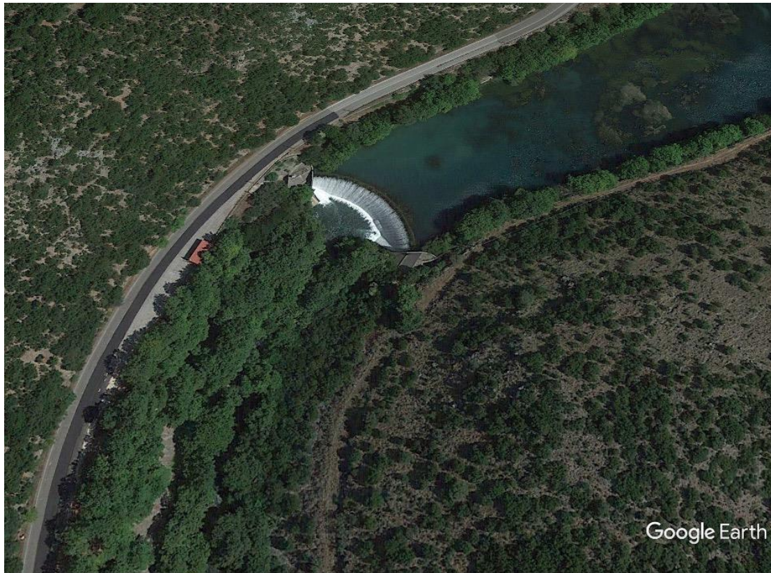
Εικόνα 2: Μικρό υδροηλεκτρικό φράγμα στον ποταμό Λούρο
