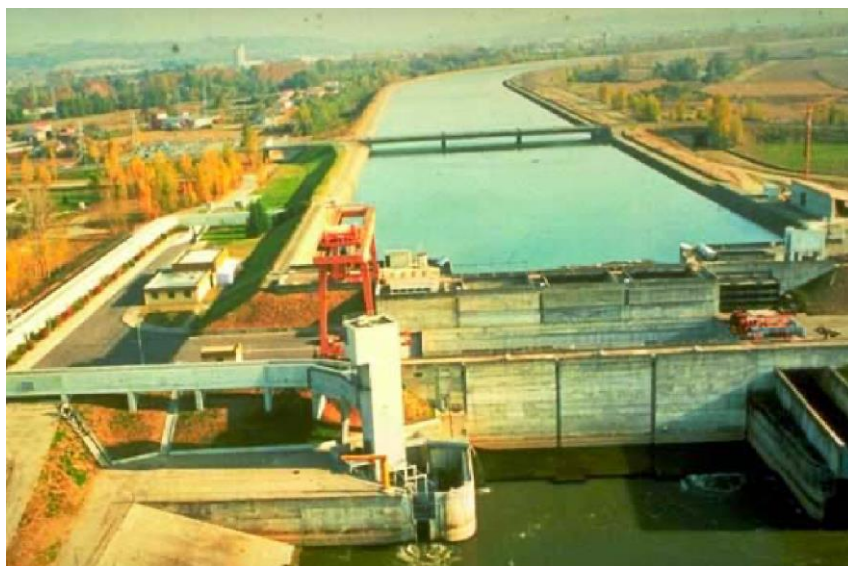
Εικόνα 15. Ανελκυστήρας ψαριών στο φράγμα Golfech, ποταμός Garonne, Γαλλία.
