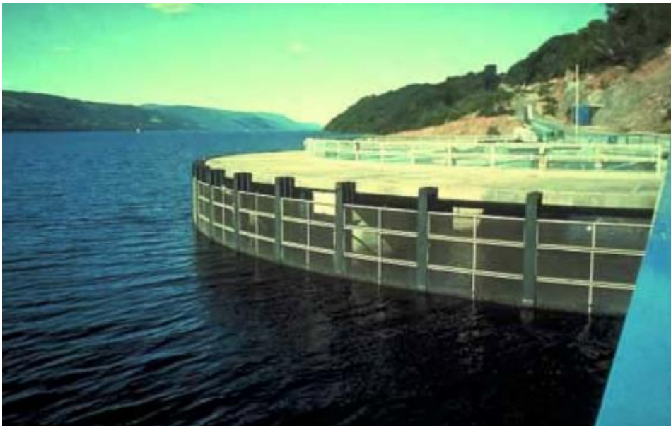
Εικόνα 24 :Λεπτό δίχτυ σε ΥΗΕ που εμποδίζει την πρόσβαση των ψαριών κοντά στους στροβίλους
