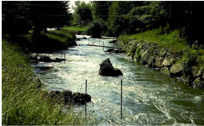
Εικόνα 14. Τύπος περάματος που προσομοιάζει με το φυσικό οικοσύστημα ©Larinier.
