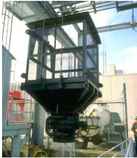
Εικόνα 22. Σύστημα μεταφοράς ψαριών, ποταμός Saint John (New Brunswick, Καναδάς).
