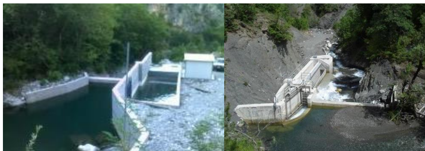
Εικόνα 1: α) Τυπικό σκαρίφημα γενικής διάταξης των έργων που συνθέτουν ένα ΜΥΗΕ. (Πηγή: Andaroodi, 2005) β), γ) Μονάδες υδροληψίας ΜΥΗΕ, Ελλάδα (Πηγή: https://www.microhydropower.gr/ )
