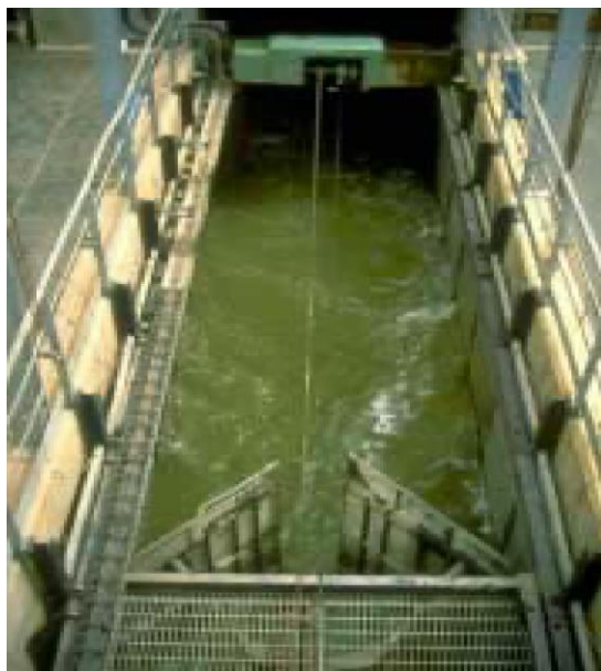
Εικόνα 17. Δεξαμενή συλλογής ψαριών και αναβατόριο στο φράγμα Golfech, ποταμός Garonne (Γαλλία).
