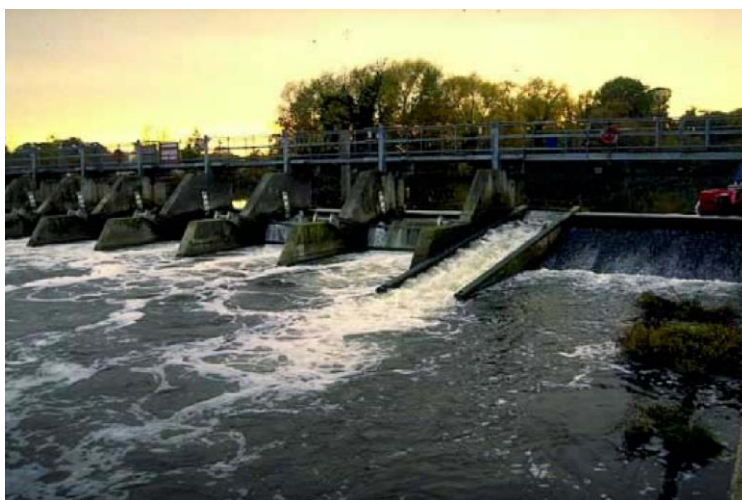
Εικόνα 11. Ιχθυοδιάδρομος τύπου DENIL. ©Larinier
