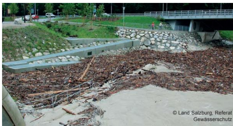
Εικόνα 25: Παρασυρόμενα τμήματα δέντρων σε ιχθυοδιάδρομο κατάντη του φράγματος που εμποδίζουν τη λειτουργία του, ποταμός Saalach, Αυστρία (MLFUW 2012).
